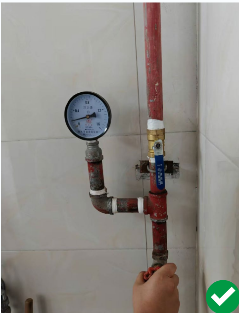
末端试水装置静水压力为 0.2MPa，满足要求
