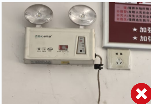
应急照明灯具采用普通插头连接且插头被随意拔出
