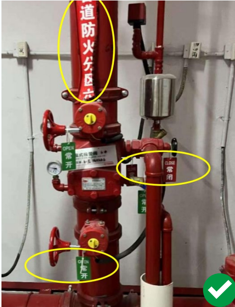
湿式报警阀组设有区域标识，阀门设有常开或常闭状态标识
