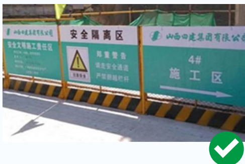
施工区与使用区进行隔离
