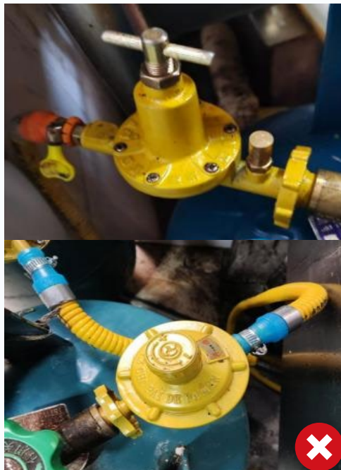
可调节压力调压器（可调式减压阀）
