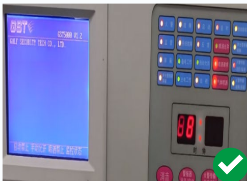
主机自检声光响应正常
