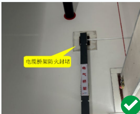
电缆桥架穿墙处封堵严密
