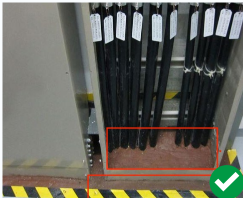
电缆井每层楼板处进行防火封堵（含桥架内外）
