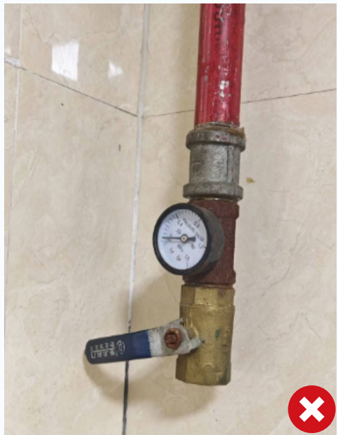
末端试水装置静水压力值为 0Mpa，不满足要求
