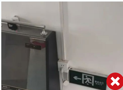
灯具插头被随意拔出，插座被其他用电设备占用
