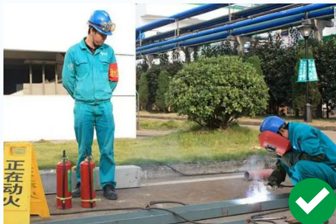
施工现场有监护人，配备灭火器材
