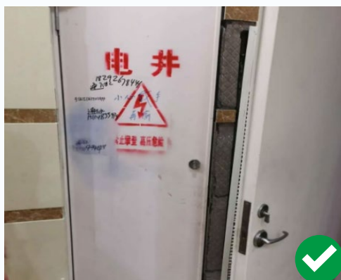
电缆井检修口安装防火门
